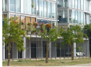
Façade sur la rue Passe Demoiselles
