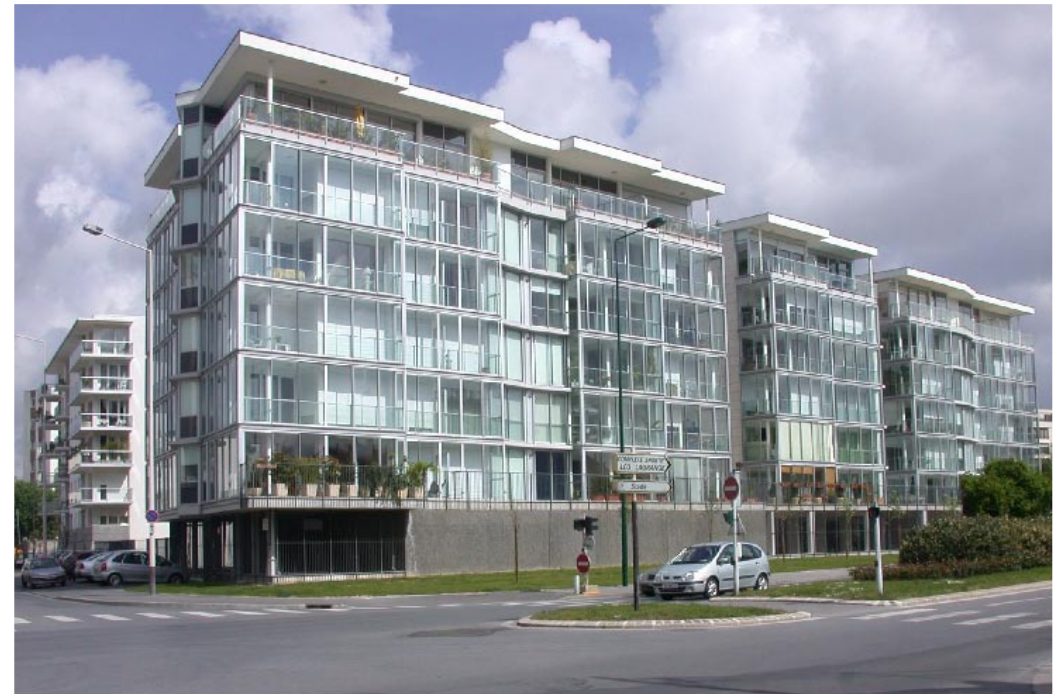
Façade sur l'avenue du Général de Gaulle
