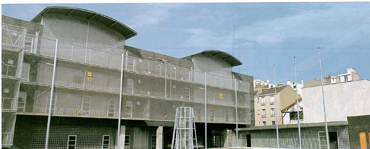
Interior do pátio de recreação, fachadas internas sul e leste
