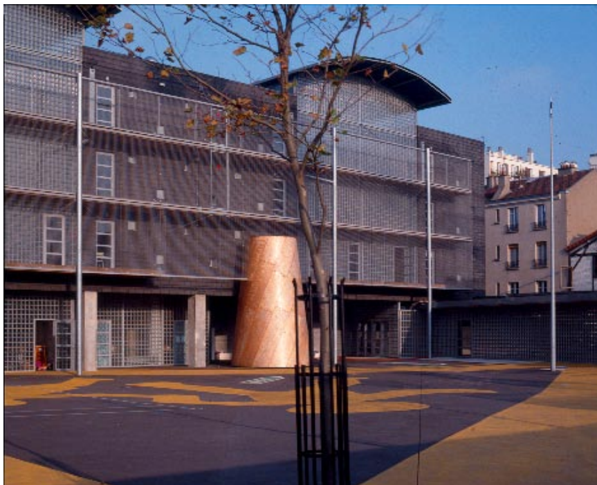
Façade sur la cour
