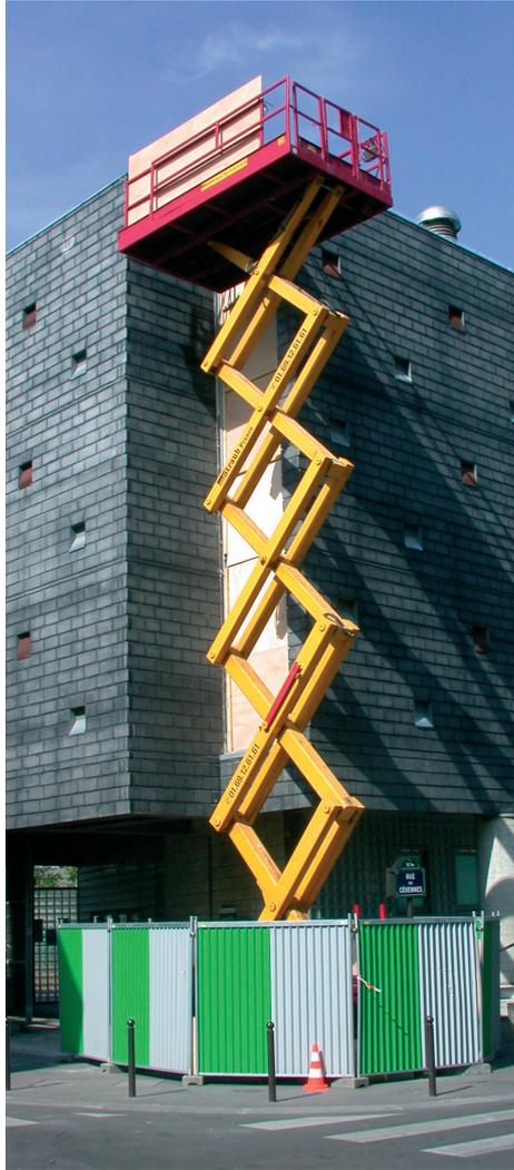
Sur les petites surfaces, nous avons choisi la location d'un élévateur plutôt que le montage d'un échafaudage
